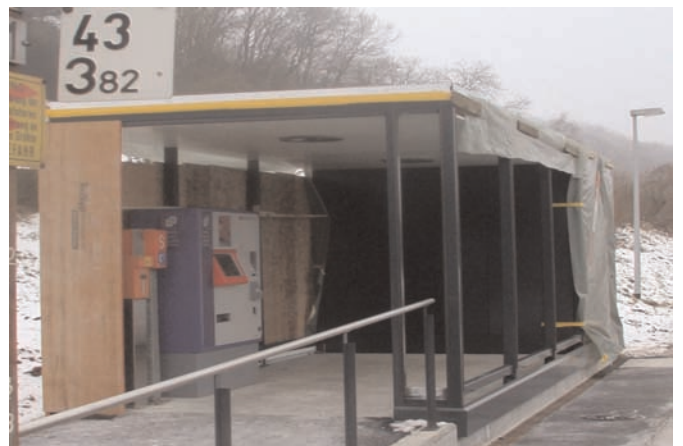
(Bild Wartehaus im Rohbau)
